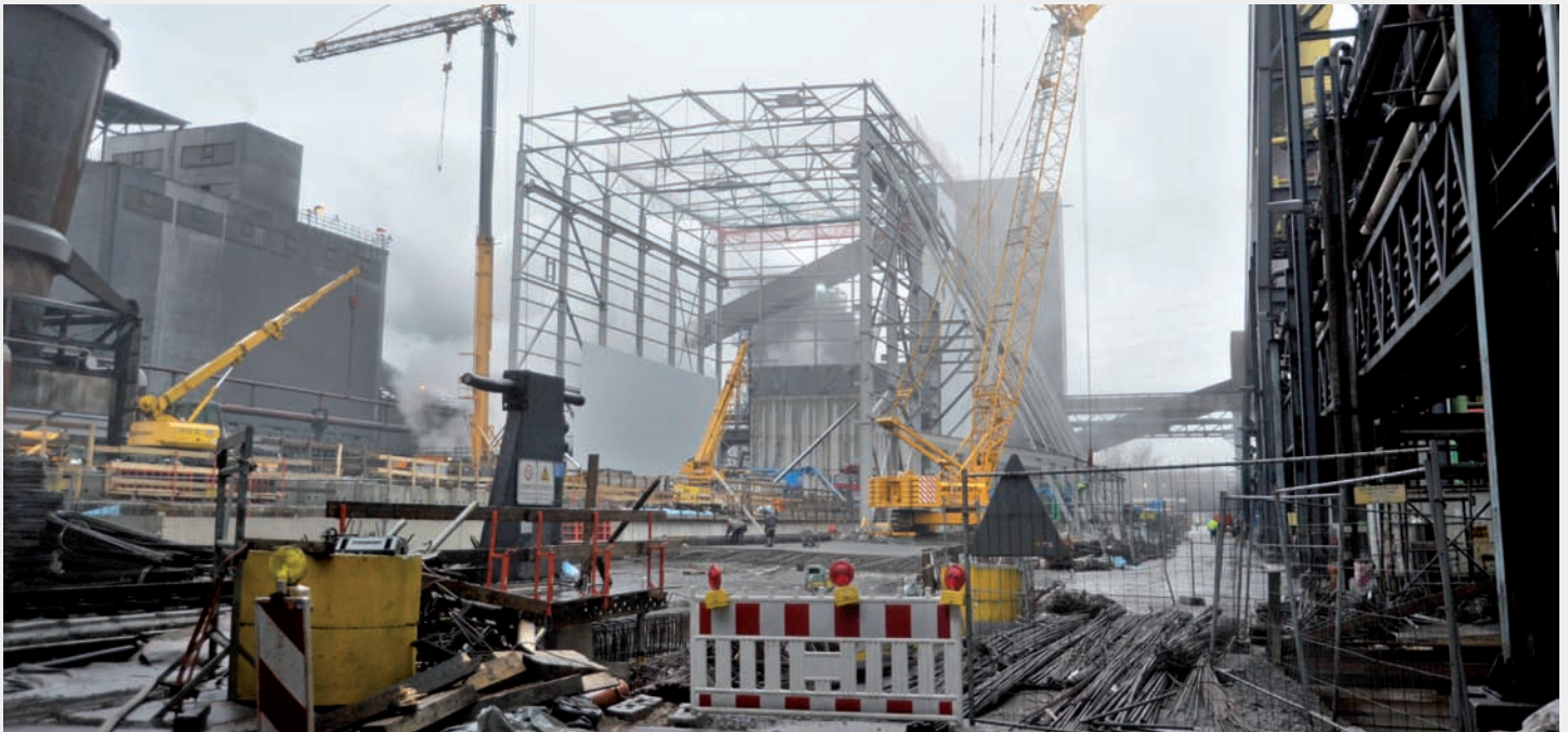
Der Beginn eines riesigen Puzzles: Die Ofenschutzhalle nimmt Gestalt an.
